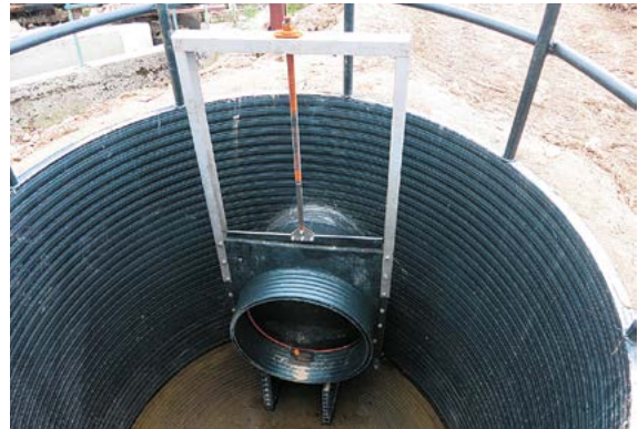
Фото 5. Колодязь-гасій із затвором аварійного скидання
