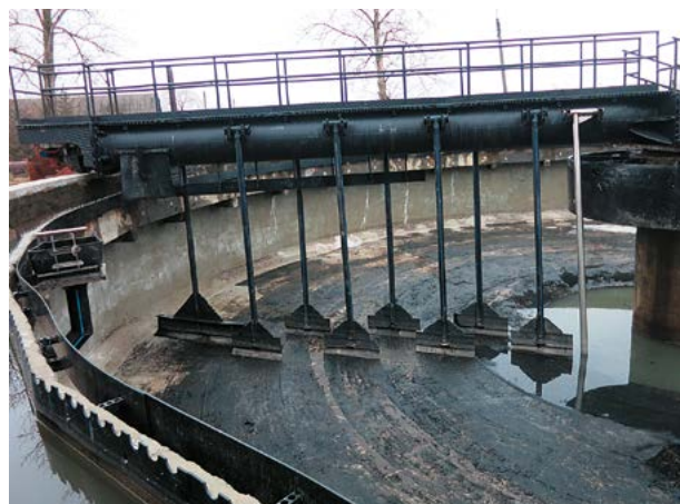
Фото 11. Муловий скребок первинного радіального відстійника
