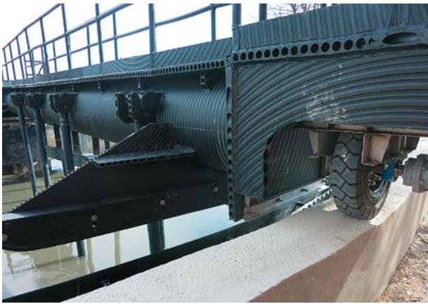
Фото 13. Привід мулового скребка
