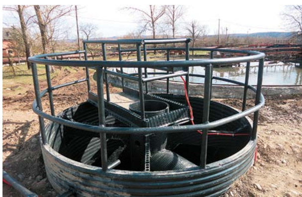
Фото 9. Пісковловлювач вертикальний
