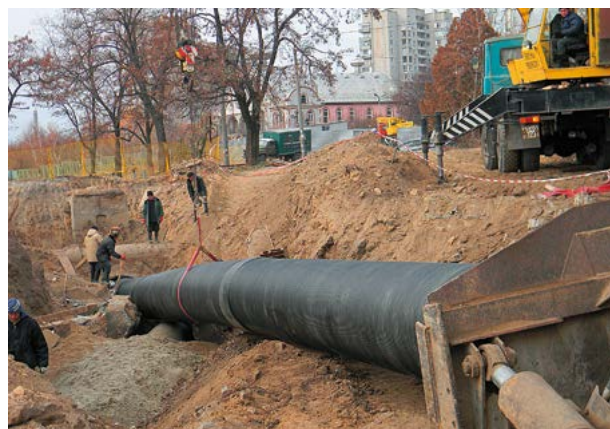
Фото 1. Санація каналізаційного колектора
